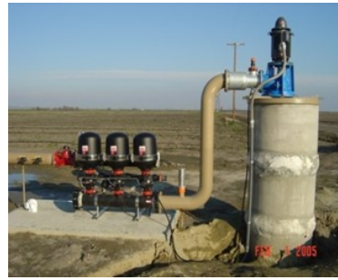
وحدة الضخ في منظومة الري بالتنقيط مع المضخة الانتبازيه الطاردة المركزية
